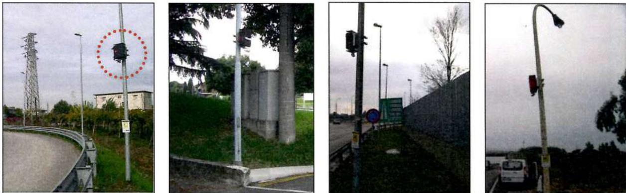
Si noti come le fasi di installazione/rimozione delle telecamere e delle apparecchiature del sistema MioVision non arrechino alcuna perturbazione al normale deflusso veicolare, in quanto il posizionamento e tutte le operazioni ad esso connesse vengono svolte al di fuori della carreggiata.
