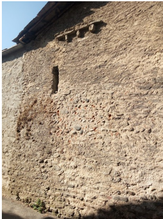
Via Marconi, tratto superstite della prima cinta muraria (visibile la muratura medievale a spina di pesce, la feritoia per la balestra e le mensole a sostegno del camminamento ligneo interno)
